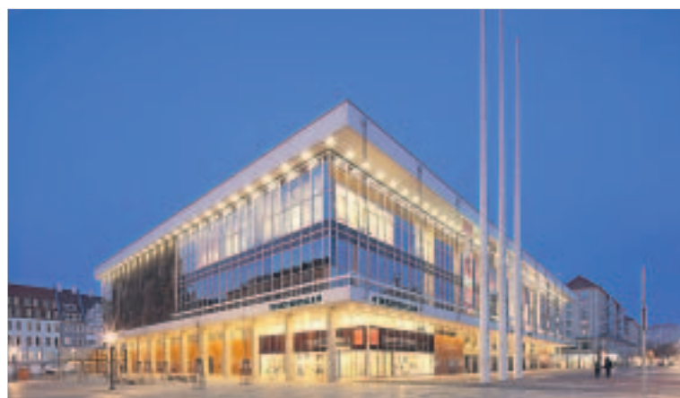
Edel sieht der Kulturpalast bei Nacht aus. Seine Sanierungsbedürftigkeit wird erst am Tage deutlich. Foto: Steffen Füssel
